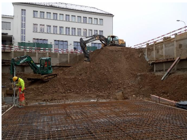
Gleichzeitig mit den letzten Aushubarbeiten wurde bereits das Fundament für den Baukran gebaut.
