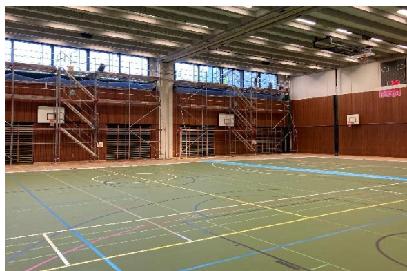
Die Fenster im Turnhallentrakt werden ersetzt.
