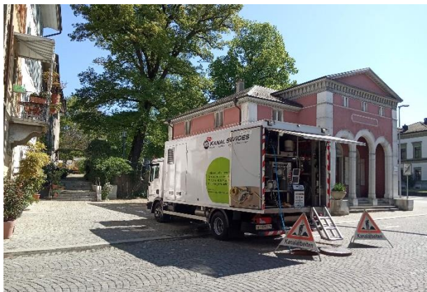
Auch in der Altstadt wurden die Hausanschlüsse der Kanalisation erfasst.
