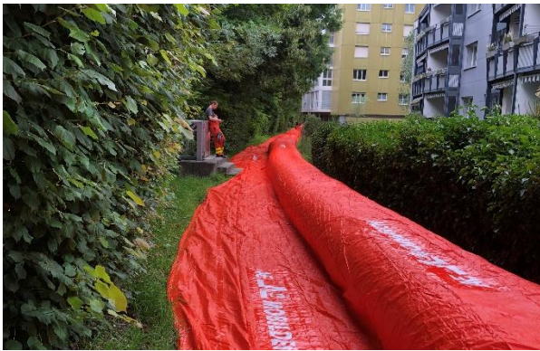
Vorsorglicher Einsatz des Hochwasserschutzsystems Mobildeich entlang der Wigger in Zofingen.
