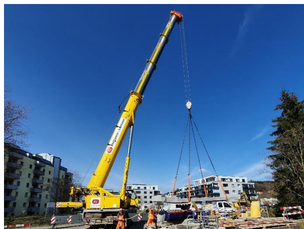
Die vorgefabrizierte Brückenplatte wird über den Dorfbach gelegt.
