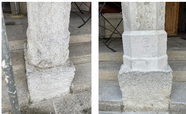
Stütze Amtshaus West: vorher/nachher
