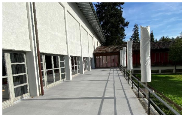
Der neue Belag der Terrasse des Stadtsaals dient gleichzeitig als Abdichtung.
