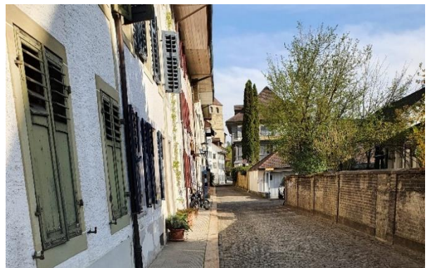
Die Ringmauergasse muss saniert werden.
