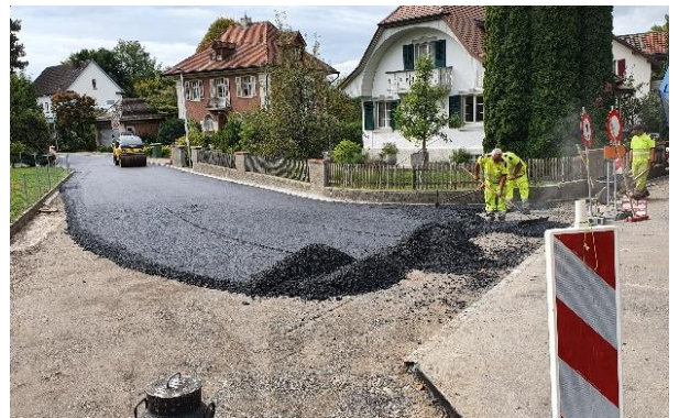
Einbau der Tragschicht im Pomernweg
