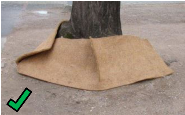
Kokosmatten von mindestens 3 cm Dicke können zur Abdeckung von Wurzelanläufen verwendet werden (Bild Stadtgärtnerei Basel).
