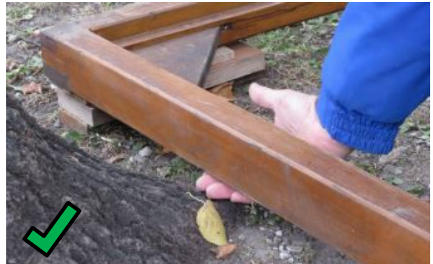
Podestbau für einen Verkaufsstand – Schutz von Wurzelanläufen und gegen Bodenverdichtung durch Abstand. In Zofingen nur mit Ausnahmegewilligung möglich (Bild Stadtgärtnerei Basel).
