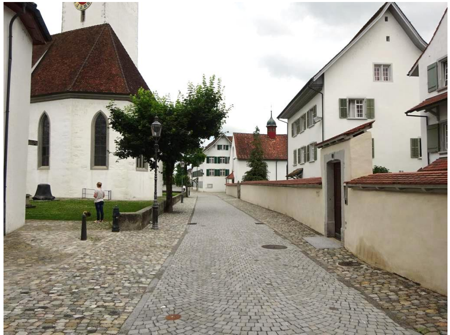
Randbereiche Wacken, Fahrbahn Guber geflammt in Bogen
