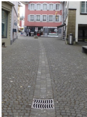
Vordere Hauptgasse, Wasserschale Typ 1 & 2
