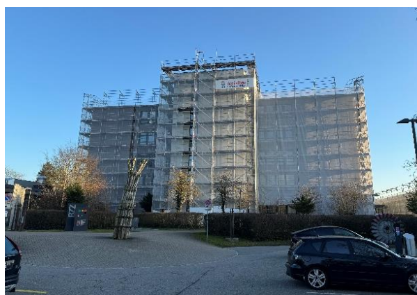
Im Vordergrund steht die Sanierung der bestehenden Gebäudehülle. Bei sieben Gebäuden werden insgesamt rund 500 Fenster ersetzt.
