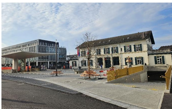
Bahnhofplatz: Die Rampe zur Velostation bietet auch mobilitätseingeschränkten Personen Zugang zu den Perrons.
