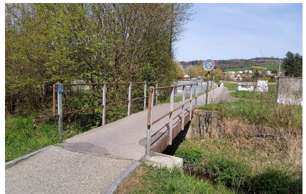
Die schmale Brücke über den Mühletych soll verbreitert werden.
