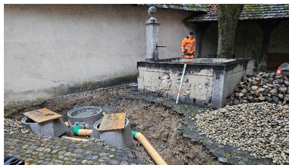
Im Höfli des Rathauses wurde eine Versickerungsanlage für das Brunnenabwasser erstellt.
