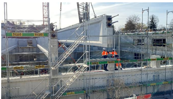
Montage von zehn je 60 Tonnen schweren Betonträgern in der Dreifachturnhalle
