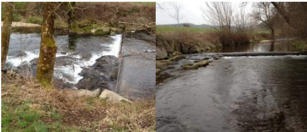
Abbildung 10 Verbesserung der Fischdurchgängigkeit an bestehenden Schwellen durch vorgesetzte Blocksteine. Beispiel von der Frenke in Bubendorf BL (Fotos: Fischereiaufseher BL, D. Zopfi, März 2015)
