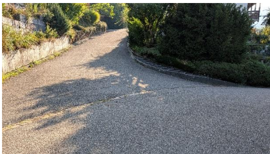
Abbildung 4: Anschluss Riedhalde, Rückbau Treppe
