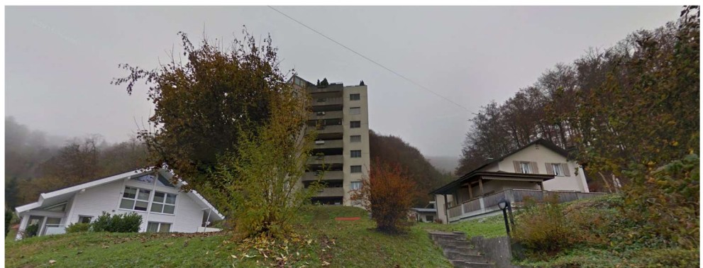
Abb. 8: Bestehender Bau mit 8 Vollgeschossen im Ortsteil Mühlethal (Quelle: Quelle: www.google.de)
