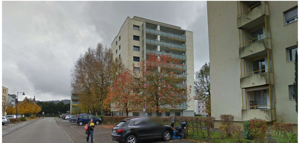
Abb. 5: Bestehende Höhere Baute an der Gotthelfstrasse (Quelle: www.google.de)
