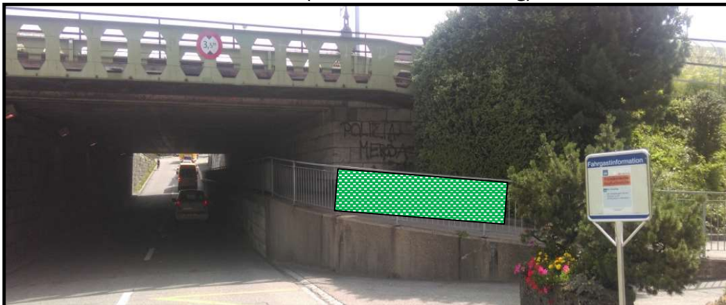
Henzmannstrasse-Florastrasse (Geländer Unterführung)
