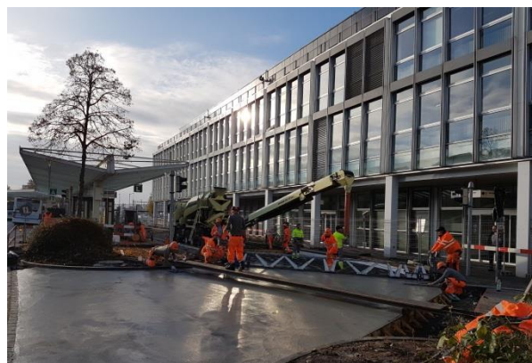
Einbau der Beton-Fahrbahn beim Busterminal
