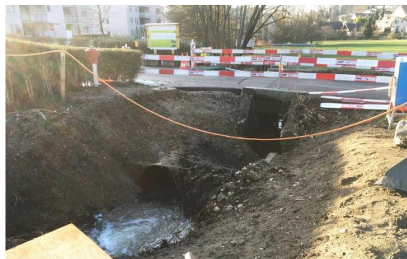
Provisorische Bachumlegung Hottigergasse
