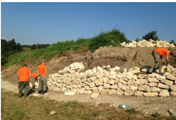
Bau einer Trockenmauer am Erlebnispfad in Vordemwald
