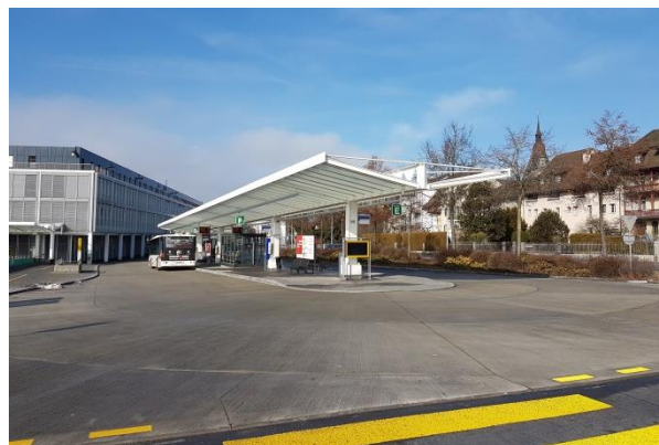
Ein grosser Teil der Fahrbahn wurde betoniert.
