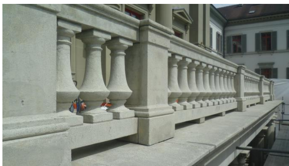
Sanierte Brüstung des Gemeindeschulhauses
