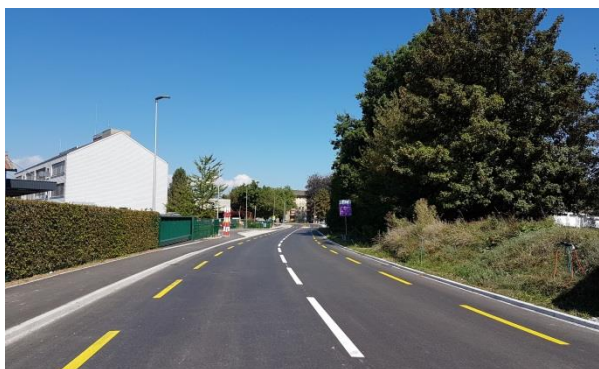
Der Abschnitt Strengelbacherstrasse – Mühlegasse ist saniert.
