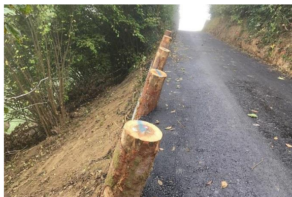
Hangstützung Sonnenwandstrasse
