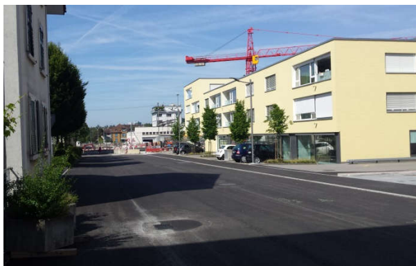
Strengelbacherstrasse nach dem Einbau der Tragschicht
