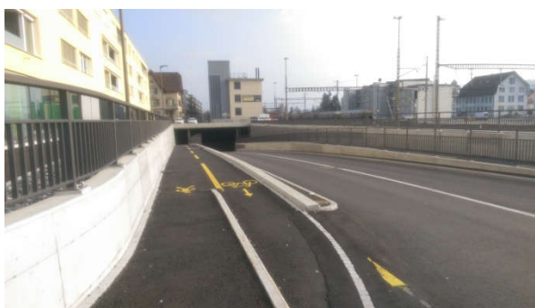
Dank der neuen Unterführung gehört das Warten vor geschlossenen Bahnschranken der Vergangenheit an.
