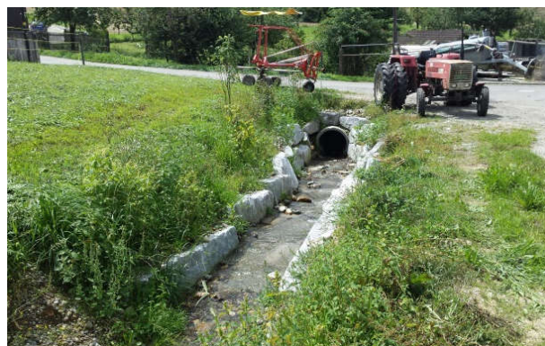
Durch die Verbreiterung respektive die Offenlegung des Baches wurde der Hochwasserschutz im Riedtal verbessert.
